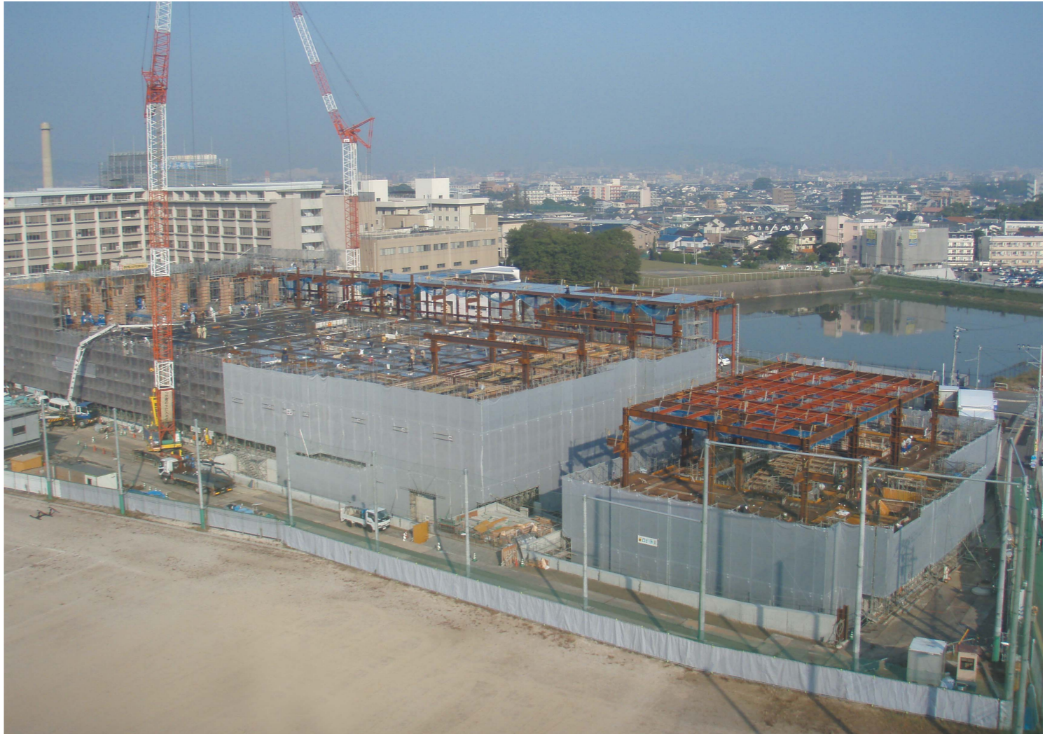
工事風景 平成21年10月現在
